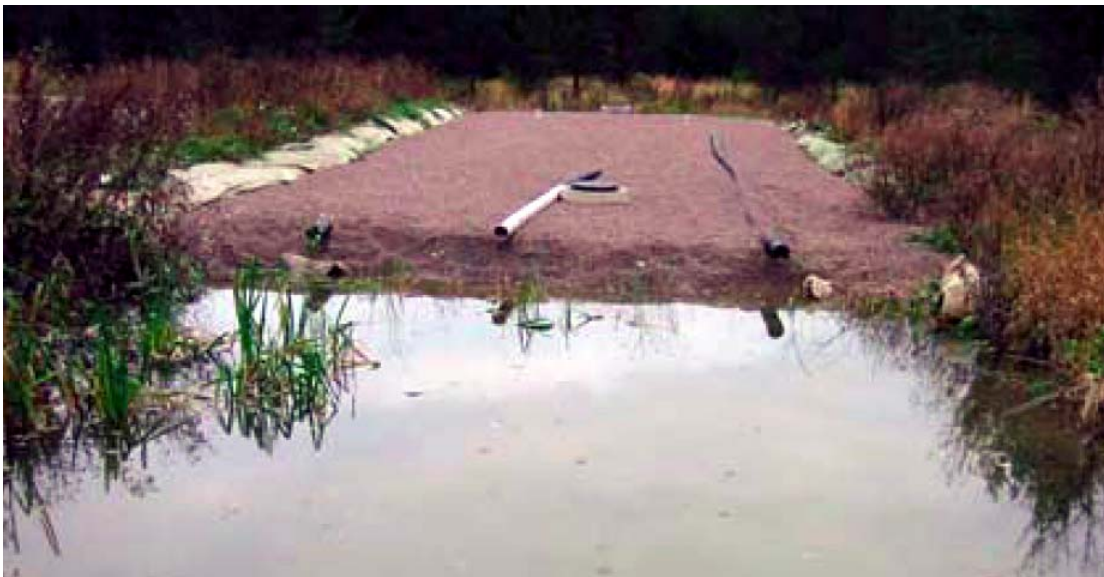
Figur 3. Exempel på passivt markfilter som har anlagts nedströms ett förorenat markområde för att hindra spridning/läckage av metallförorening i samband med schaktning av förorenad jord (Johan Helldén AB / Helldén m.fl., 2006).
