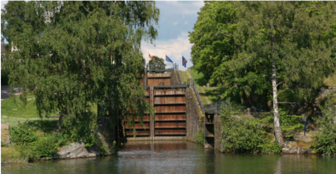
Sluss i Trollhättan. Riksintresse och kulturmiljö. Foto: Trollhättans kommun.
