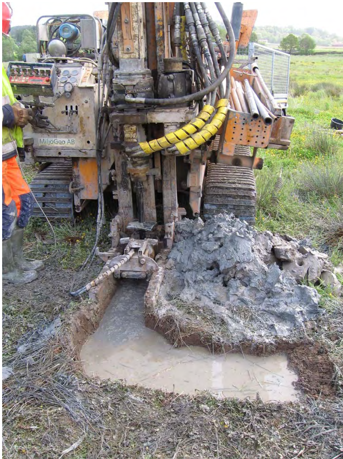
Figur 9 Fångdamm för bentonitväska
