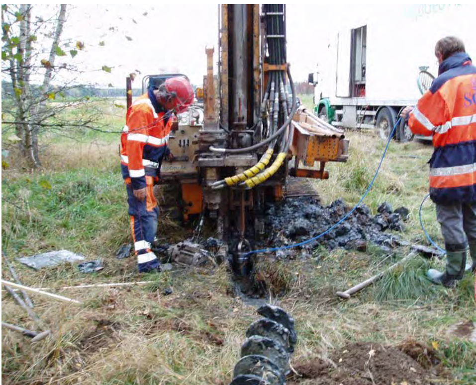
Figur 12 Provtagaren på väg ned. I förgrunden syns fångdamm och jordskruven.
