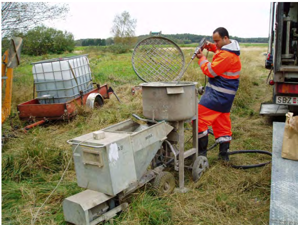
Figur 6 Blandning av bentonitvätska
