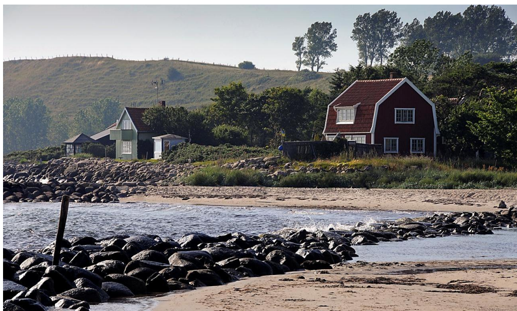
Figur 5.5 Erosion längs kusten i Löderup. Erosionsskydd i form av stora block har lagts ut för att förhindra ytterligare förlust av mark.
