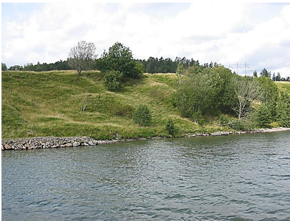
Figur 3.4 Slänt med spår av tidigare erosions- och skredskador samt erosionskydd i form av strandskoning. Erosionskyddets prestanda varierar längs sträckningen i fotot.
