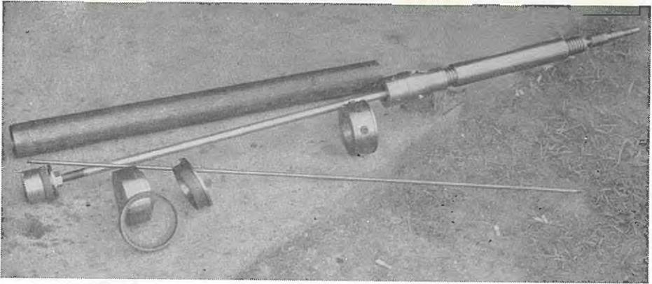
*Fig. 6. Hvorslev's sampler.*
