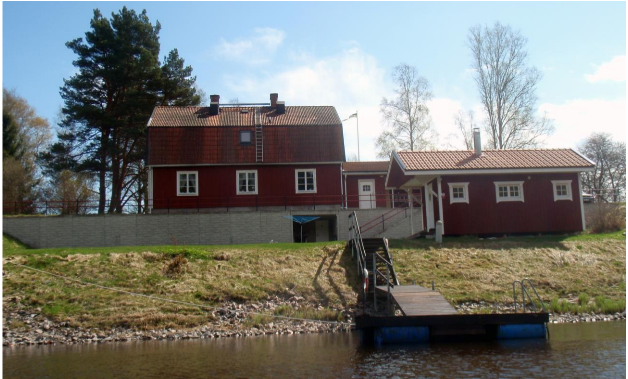
Figur 12.4 Exempel på utförda åtgärder längs Norsälven, avschaktning och erosionsskydd. Foto SGI.
