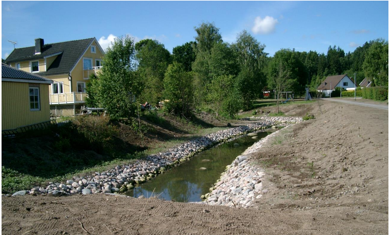
Figur 12.2 Exempel på utförda åtgärder (exempel från Orust). Avschaktning och erosionsskydd. Foto SGI.
