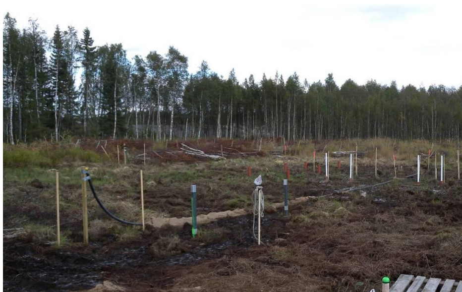
Figur 3.4 Installerad horisontalslang. (Foto SGI).
