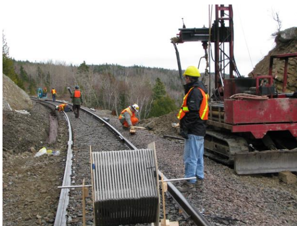
Figur 3.9a Foto på deformationskabel (SAAF) vid installation längs järnväg. (Från Cautus Geo AS 2013).
