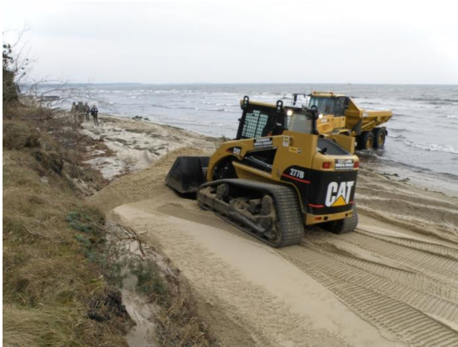
Figur 57 Strandfodring längs kusten, exempel från Åhus i Skåne (Foto: SGI).
