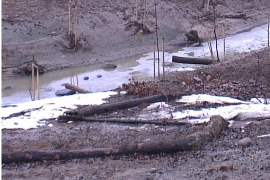
Figur 47 Stockar nedgrävda i sida på vattendraget för att minska vattenhastigheten samt ge andra biologiska effekter (Foto: P. Danielsson, SGI).
