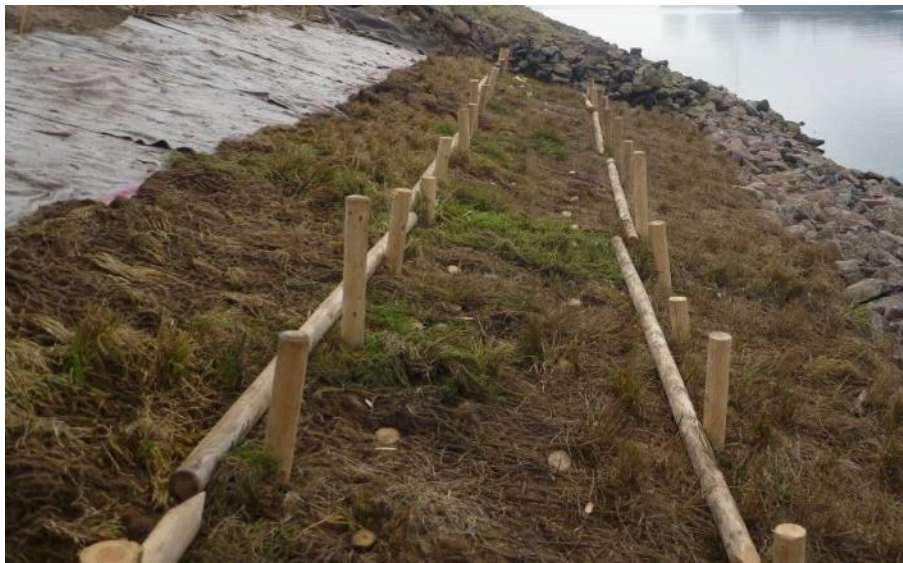
Figur 34 Geotextil med växter längs Rhen vid Worms, Tyskland (Foto: BAW).
