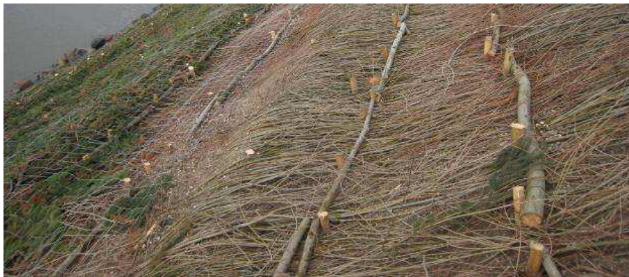
Figur 36 Mattor av grenar fixerade med trädgrenar (Foto: BAW).
