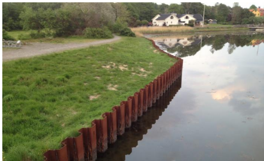
Figur 59 Spont som erosionsskydd, Amundön, Göteborg (Foto: P. Danielsson, SGI).
