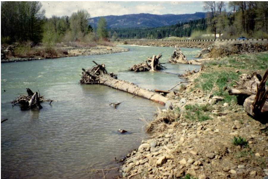
Figur 52 Exempel på styrfenor av död ved (Cramer, 2003. Foto: WDFW).
