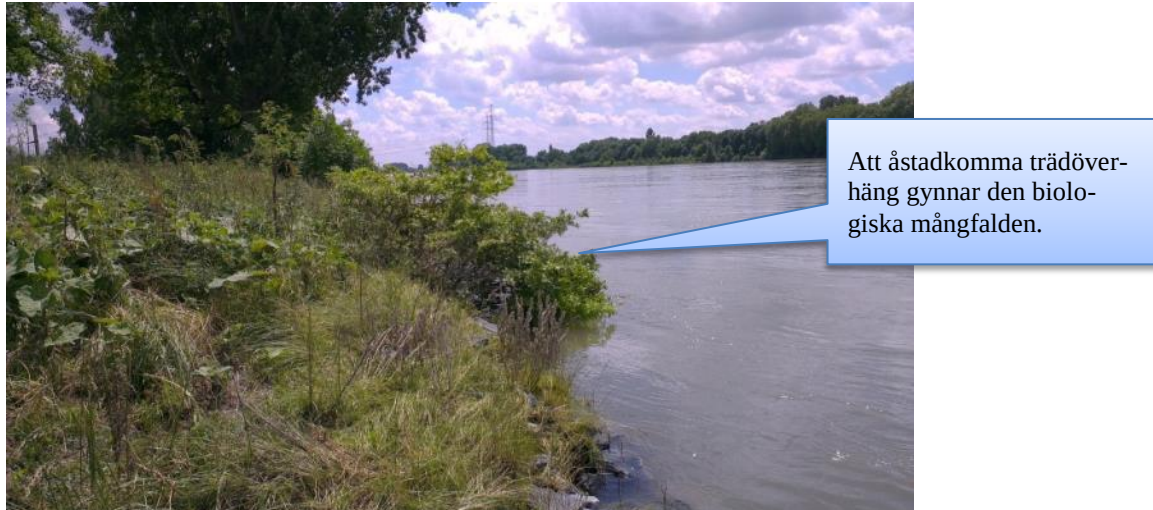
Figur 33 Träd och buskar som erosionsskydd längs Rhen vid Worms, Tyskland (Foto: P. Danielsson, SGI).
