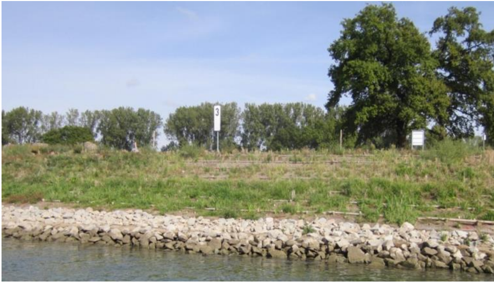
Figur 41 Stenskonig med växter över medelvattenytan (Foto: BAW).
