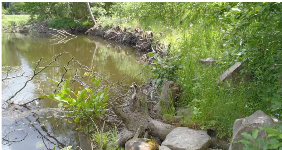
Figur 48 Exempel på stockar och rötter som erosions-skydd (Foto: Norconsult, 2014).
