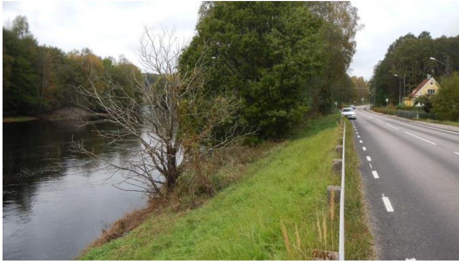
Figur 29 Gräs som erosionsskydd i en vägbank, Nissan (Foto: P. Danielsson, SGI).
