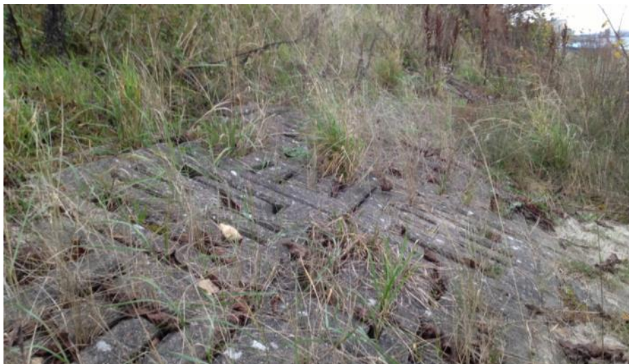
Figur 46 Betonghålblock med växtlighet (Foto: P. Danielsson, SGI).
