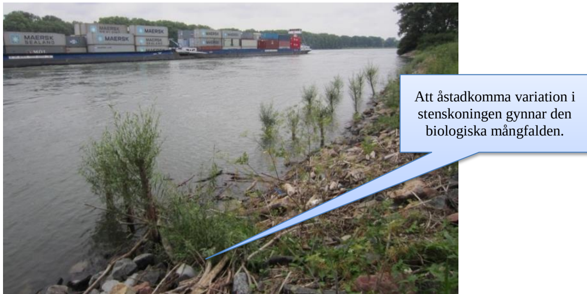
Figur 43 Stenskoning i kombination med träd och buskar (Foto: BAW).
