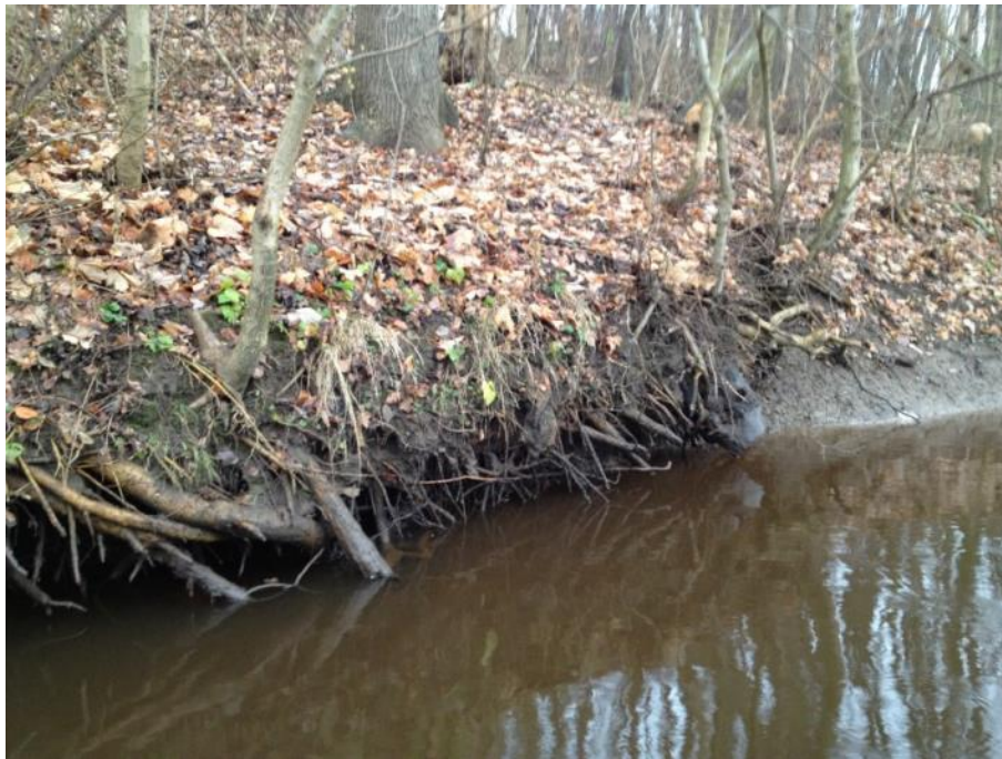
Figur 32 Exempel på hur rotsystem skyddar mot erosion i den erosionsutsatta strandbrinken, Rönne å (Foto: P. Danielsson, SGI).
