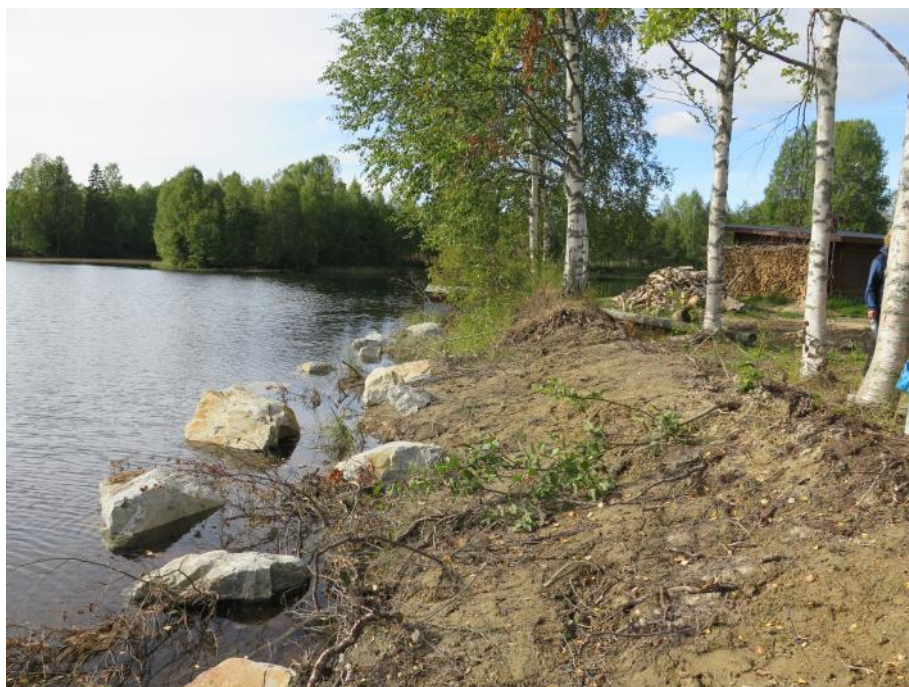
Figur 56 Naturanpassat erosionsskydd i Umeälven. Stenblock utplacerade för att hålla isen stilla då vattendraget regleras varje dygn (Foto P. Danielsson, SGI).
