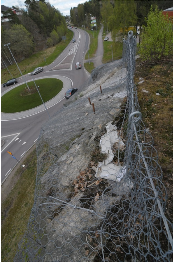
Figur 15. Ovansidan på slänten efter slutlig förstärkning 2016. Tre rostfärgade förankringsstag ses centralt i bilden. Foto: Johan Berglund.
