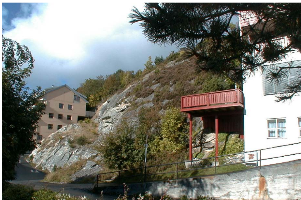
Figur 8. Området som det såg ut innan byggnation. Foto: Steinar Trygstad
