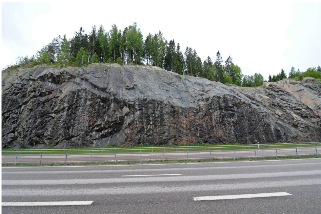
Figur 11. Slänten är sprängd med lutning 5:1, men här ses i övre delen en flackare lutning där ras under byggentreprenaden skedde utmed förskiffringsplan. Foto: Johan Berglund.
