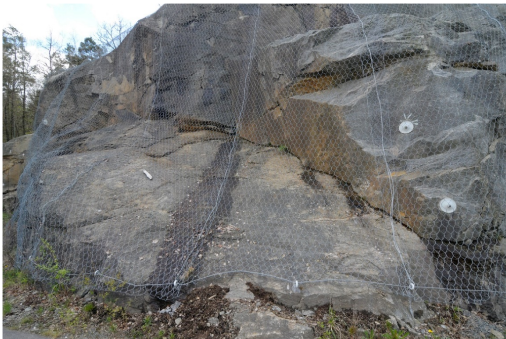
Figur 18. Bild på hörnet i slänten, efter utförd förstärkning 2015. Foto: Johan Berglund.
