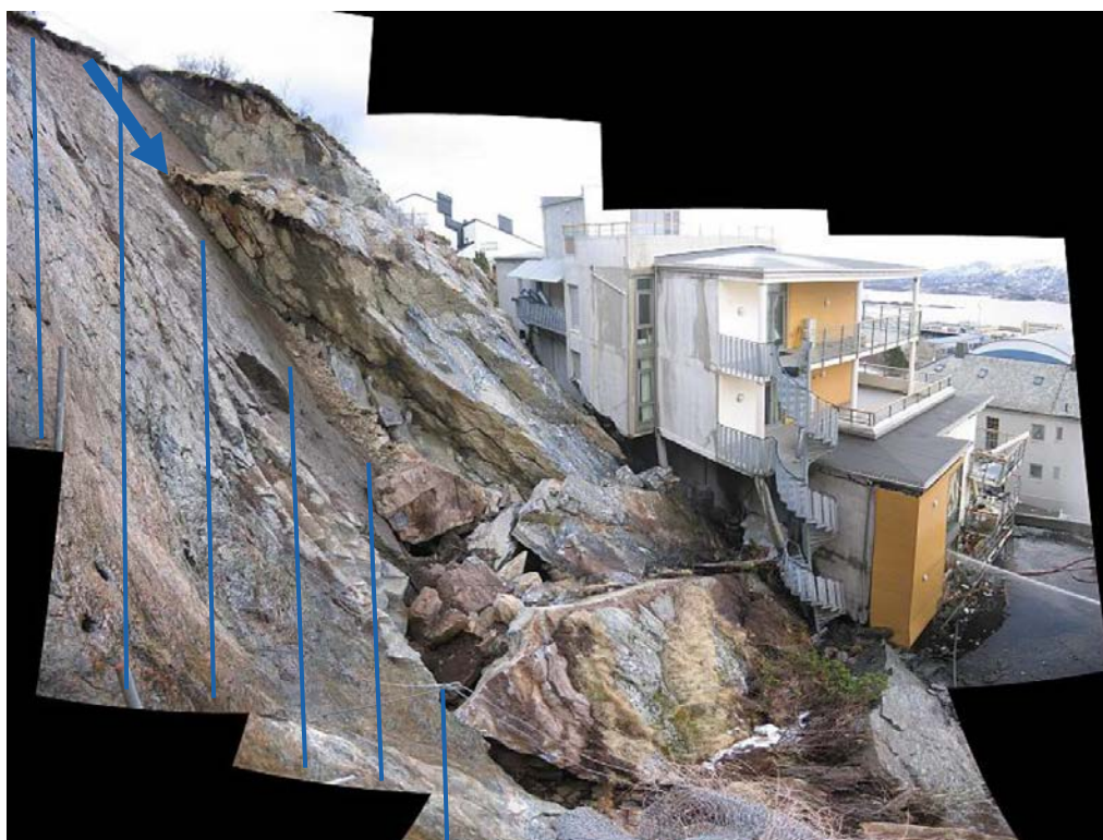
Figur 10. Sammansatta bilder tagna från grannfastigheten strax efter raset, med den drabbade byggnaden. Den blå pilen pekar på rasets överkant och även den blottlagda delen av glidytan är markerad. Figuren hämtad ur Befring et al. (2008), men blå markeringar är vårt tillägg.
