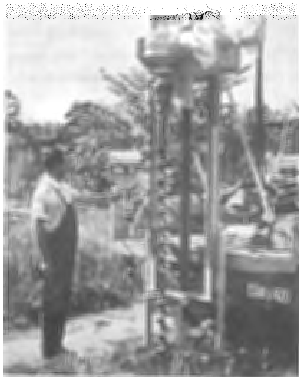
Fig. 5. Augerbormaskin B 30
