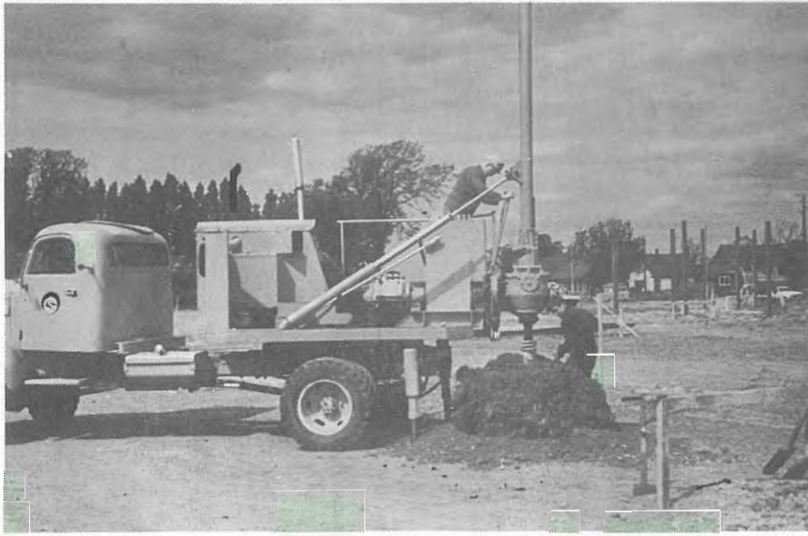
Fig. 5. Provtagningen med den specialkonstruerade provtagaren sker med en kraftig jordborrmaskin monterad på en terränglastbil.
