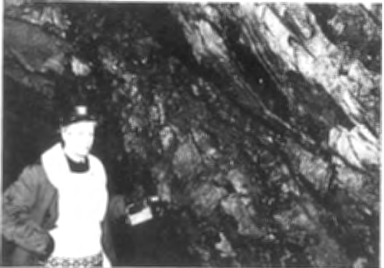
Fig. 11 Rätan tailrace tunnel, section 2075.
