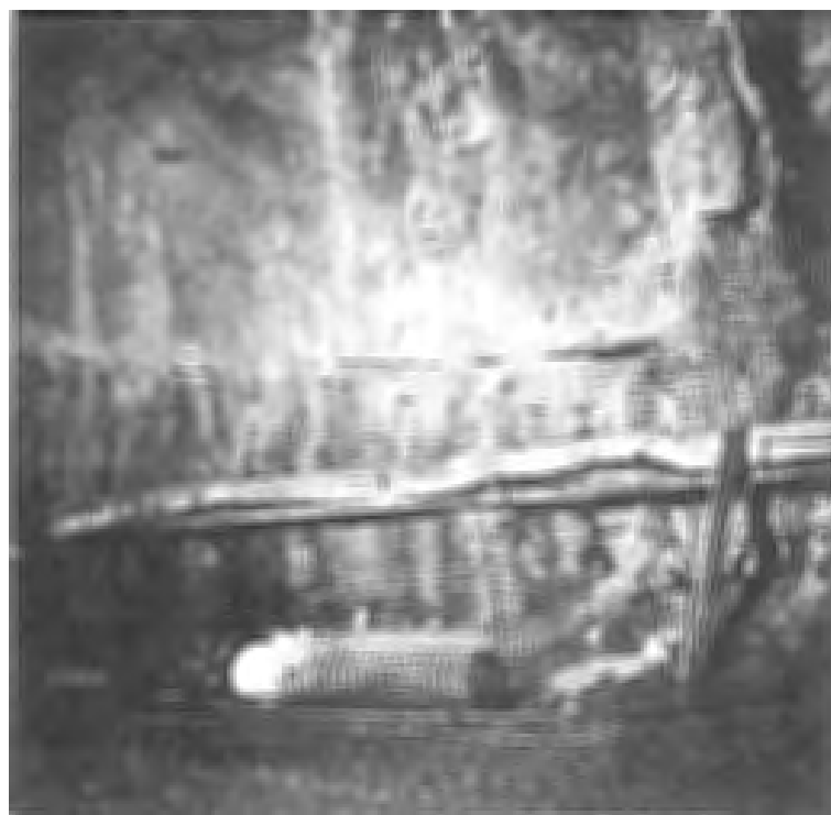
Fig. 19. Förstärkning av den i fig. 18 visade zonen med armerad sprutbetong. Foto förf.
