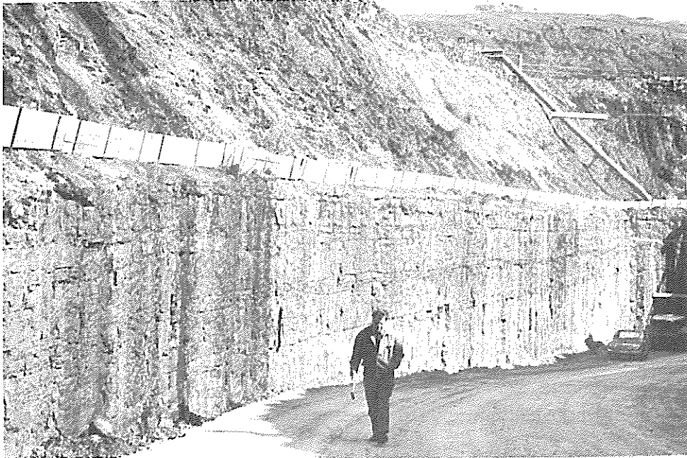
Fig. 10. Bergskärning i Kvarntorp (Närke). Den vertikala väggen nederst i skärningen bildas av underkambrisk sandsten med en del leriga skiktytor. Sluttningen ovanför väggen består av lätt sönderfallande mellankambrisk lerskiffer. Överst en lägre, vertikal, vägg av alunskiffer. I bakgrunden fyllningsmassor av alunskiffer. Foto förf.
