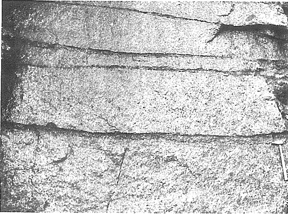
Fig. 5. Smala vittrade stråk i frisk granit. Bastusels kraftstation (Skellefte älv), avloppstunnel. Foto förf.
