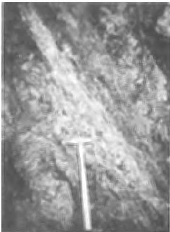
Fig. 3. Diffusa gränser mellan leromvandlat och friskt berg. Seitevare kraftstation (Blackälven), inspektionstunnel. Foto förf.
