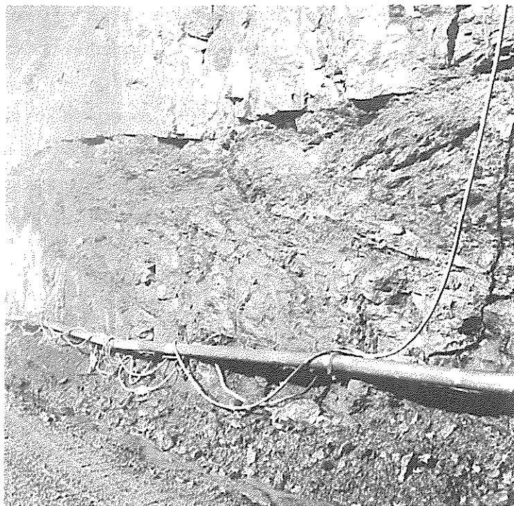
Fig. 18. Överskjutningszon under mylonitskollan väsentligen bestående av krossad, delvis grafitisk, skiffer (sannolikt från Hyolithesonen). Jmf. fig. 6 och 19. Tunneln Suorva-Vietas, sekt. 3 + 970 m. Foto H. Olofsson.
