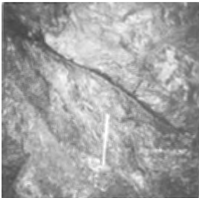
Fig. 2. Skarp gräns (pilen) mellan leromvandlat (nedre delen av bilden) och friskt berg. Letsi kraftstation (Lule älv), avloppstunnel. Foto förf.
