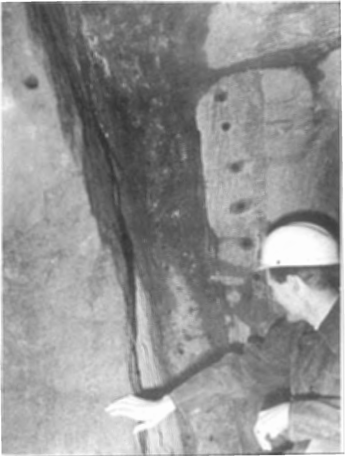
Fig. 7. I det fasta berget skarpt avgränsad zon med svällande egenskaper.
