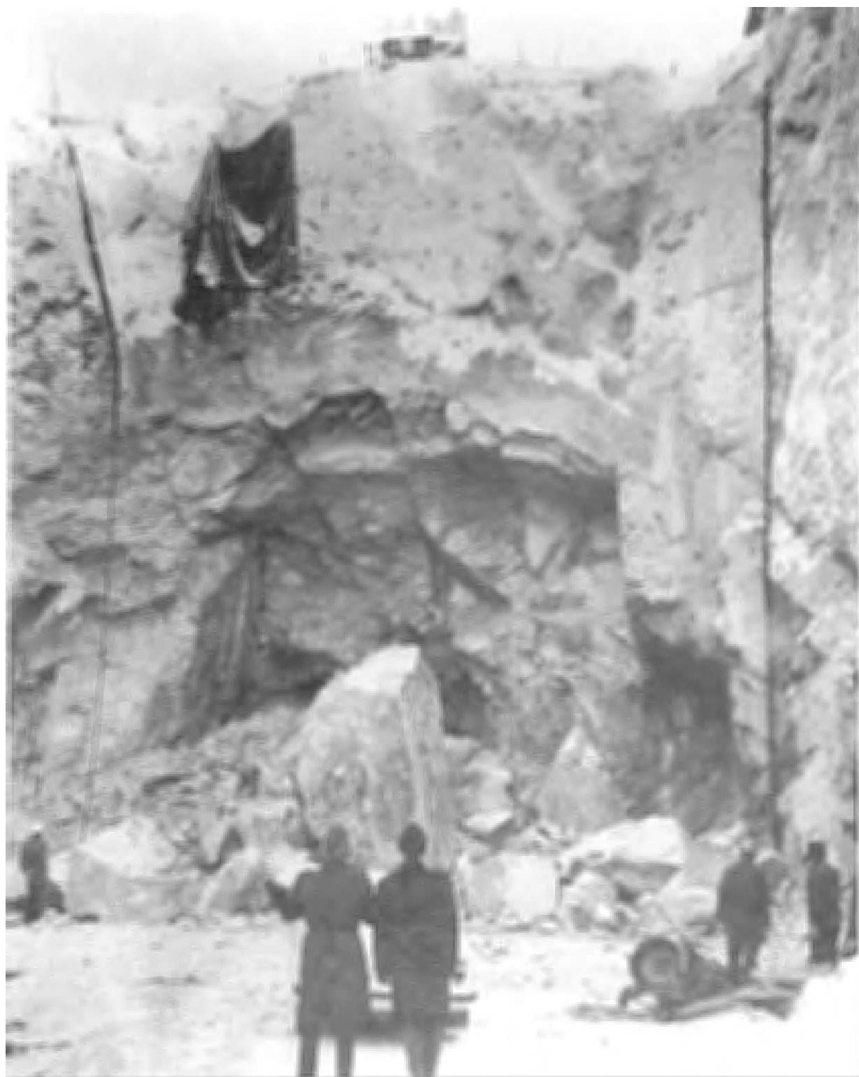
Fig. 2. Bergras i avloppstunnel vid Hällby kraftverksbygge. Raset orsakades av lerfyllda sprickor i berget.
