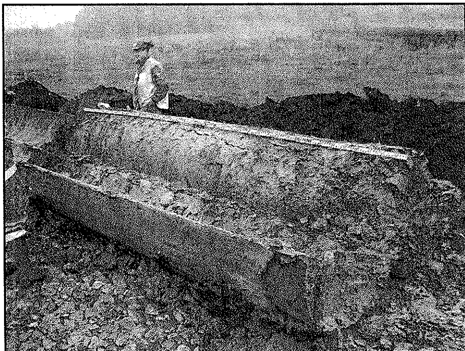
Figur 4.23. Pelare A6 när röret öppnats.
