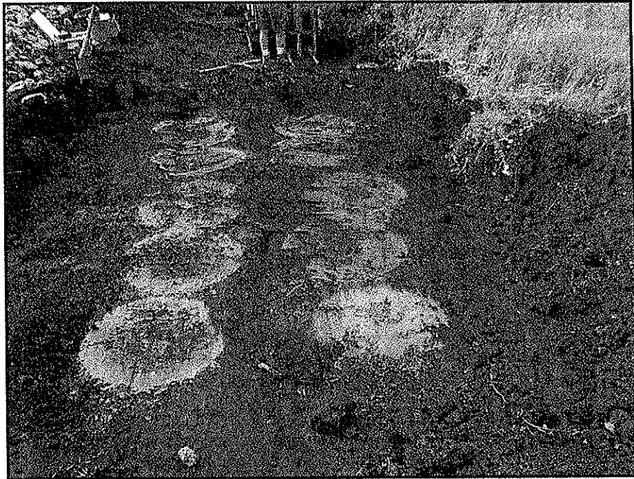
Figur 3.17 Framgrävda pelare klara för sondering
