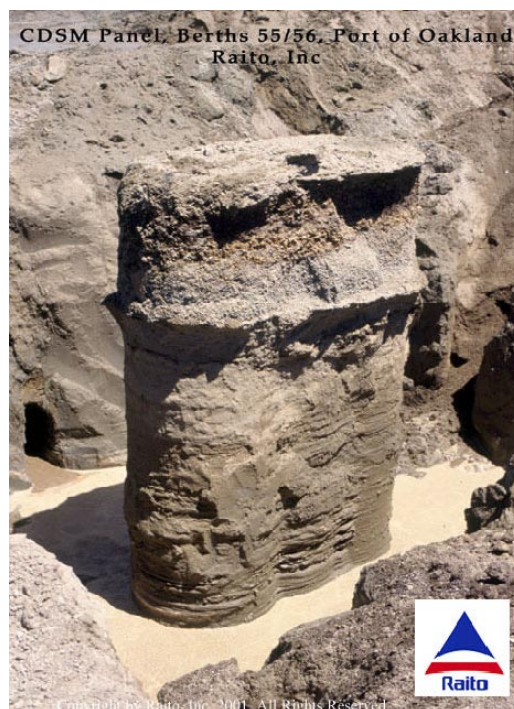
Figur 10. Blandningsverktyg vid ”double shaft” vid våta metoden samt framschaktade pelare. (P23 Yang)
