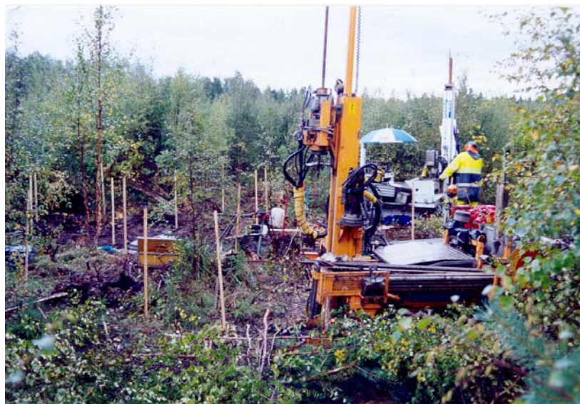
Figur 4-9 Provtagningsområdet med två borrhandsvagnar. Stakkäpparna markerar borrhålens läge.
