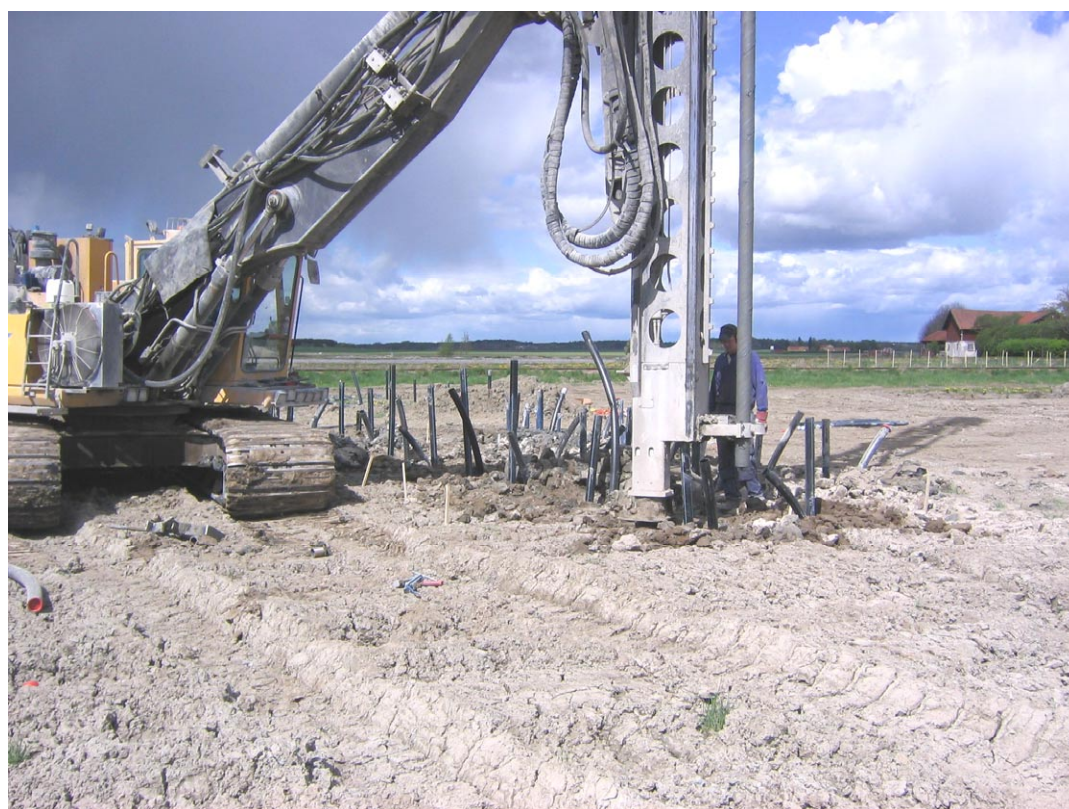
Figur 6. Installation av pelare med plastslangar och –rör för geofoner och exciteringskälla.
