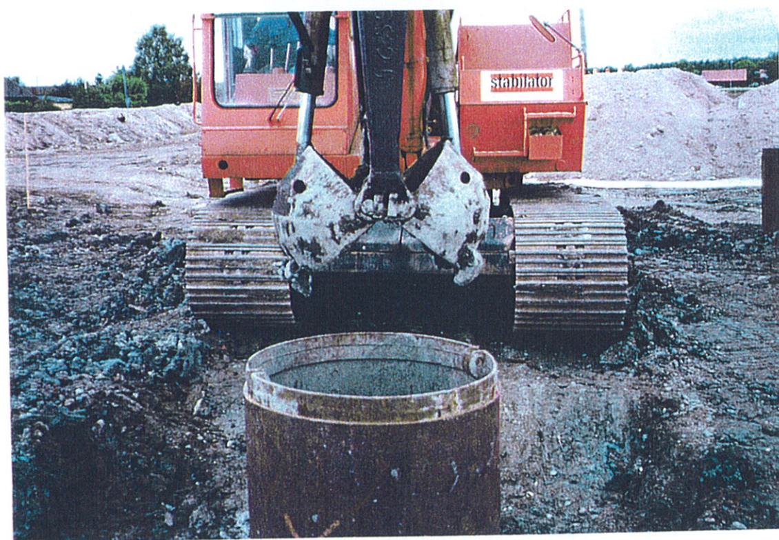
Schaktning inuti foderröret med gripskopa. För att jämna till botten utfördes sedan hand- schaktning.
