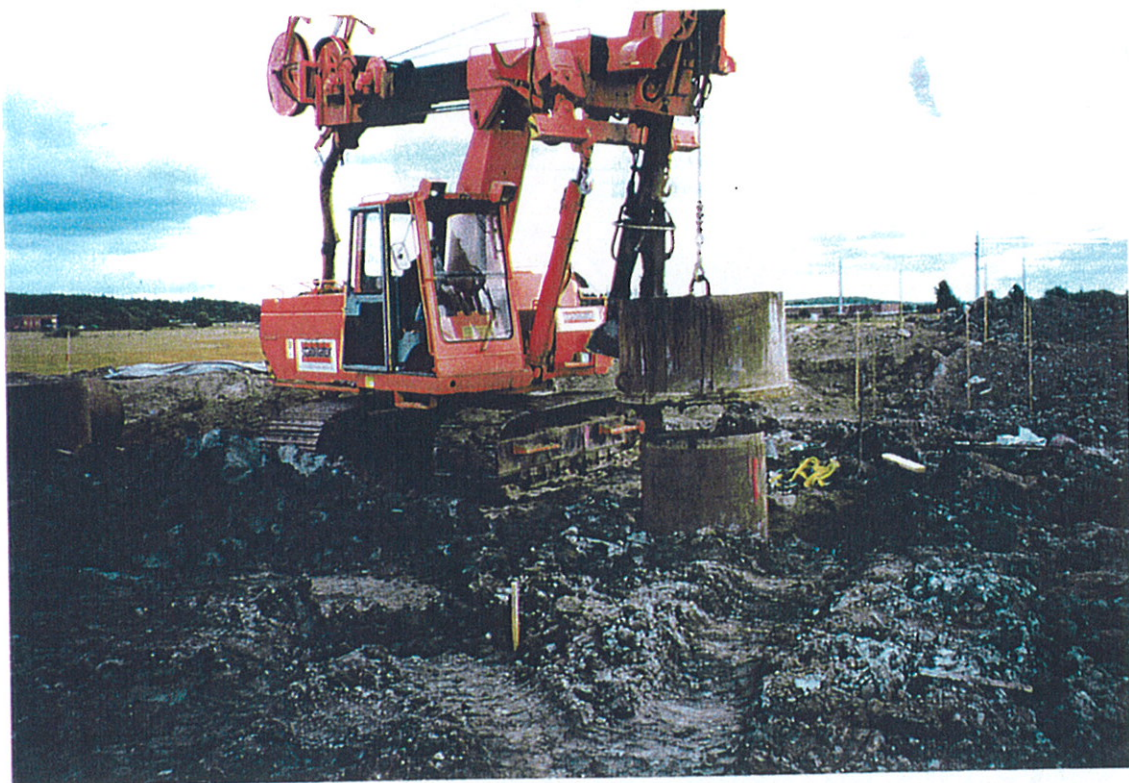
Foderröret slås ned med en jordfylld vikt.
