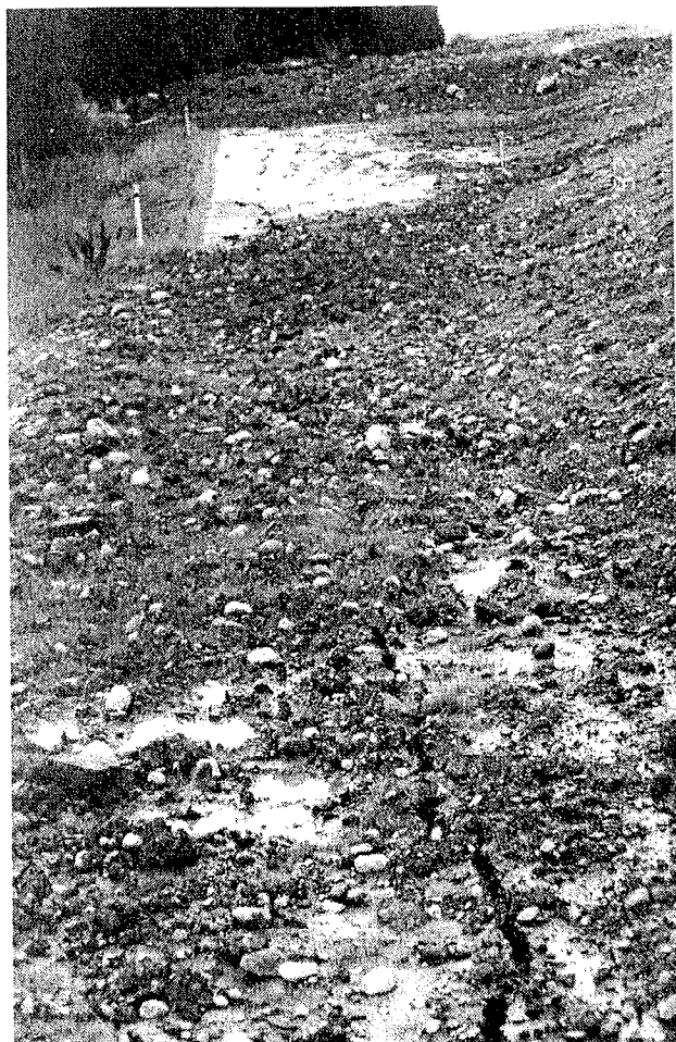
FIGUR B1 :10 Prästtjärn. Spricka i gamla E4 1993-09-06. Vy mot söder.
