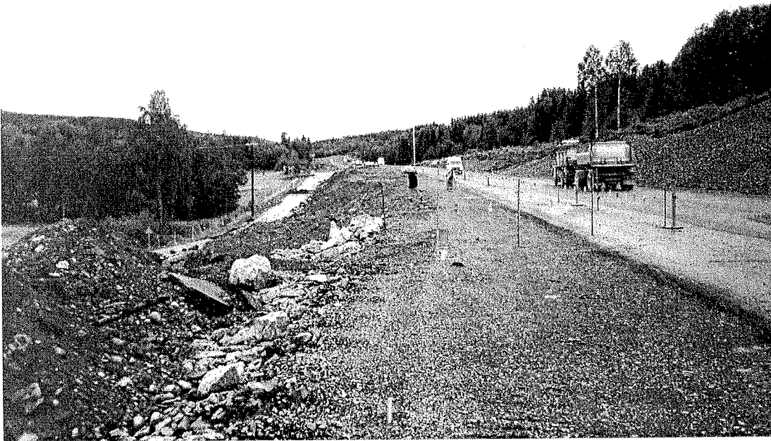
FIGUR B1:6 Humpsjön. Övervakning genom avvägning av mätdubbar.
