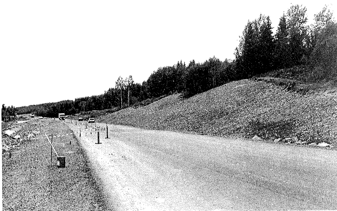
FIGUR B1:4 Humpsjön. Översikt av skärningen i den övre slänten. Mörkare partier antyder utsipprande grundvatten.
