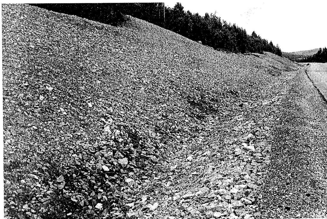
FIGUR B1:5 Humpsjön. Detalj av den övre skärningsslänten. Mörkare partier antyder utsipprande grundvatten.
