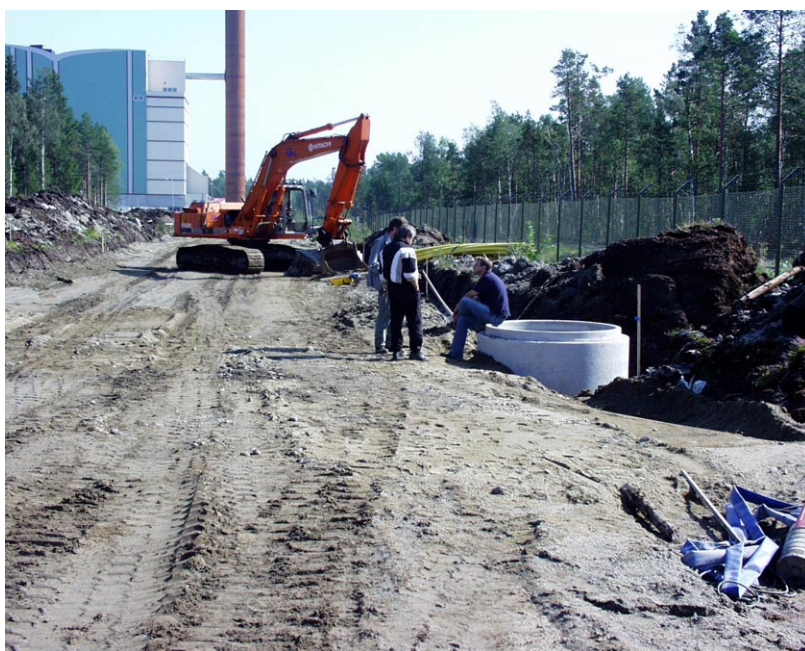
Figur 3.1. Provvägen i Dåva där skyddslagret av sand håller på att läggas ut på den avbanade terrassytan. På bilden ses också den undre delen på en brunnarna där uppsamlingsutrustning för lysimetervatten installerades.
