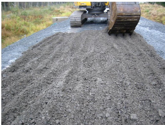
Figur 5.1. Provvägens yta luckras upp för att möjliggöra infiltration.
