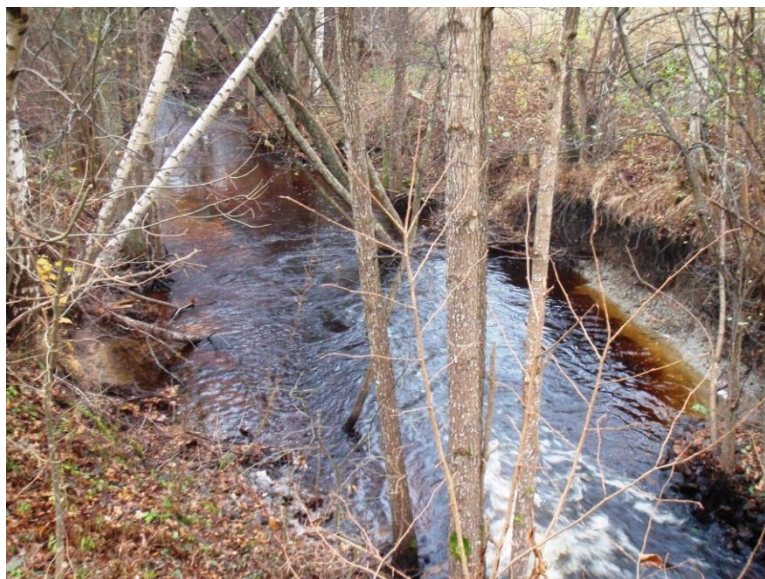
Figur 6-21. Erosionsskador syns tydligt vid en inspektion i fält (foto: SGI)
